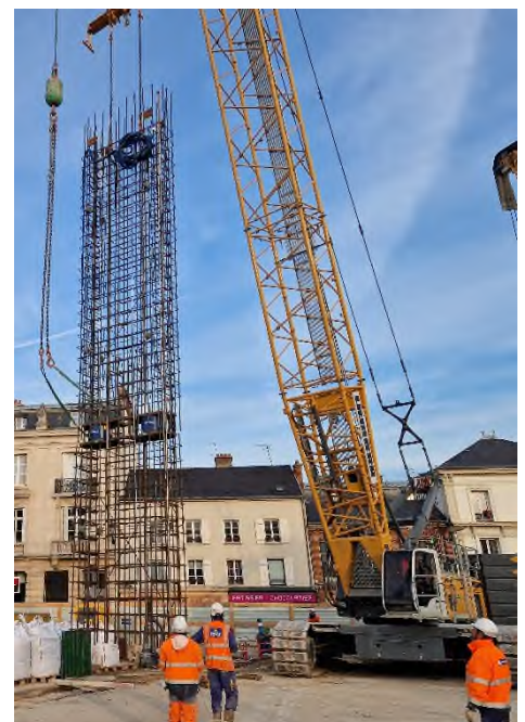
Instalação de uma armadura com O-Cells
